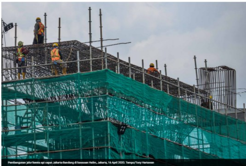
Pembangunan jalur kereta api cepat Jakarta-Bandung di kawasan Halim, Jakarta, 16 April 2020. Tempo/Tony Hartono
